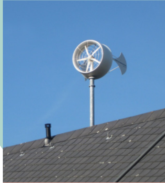
Abb. 15 Kleinwindkraftanlage auf Hausdach (Quelle: Martin Steinestel)
