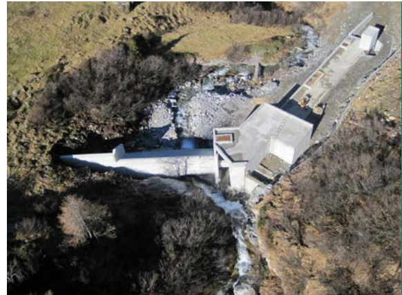
Abb. 8 Einlaufbauwerk (Quelle: Entegra AG)
