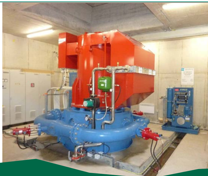
Abb. 10 Pelton-Turbine (Quelle: Bayerische Landeskraftwerke)
