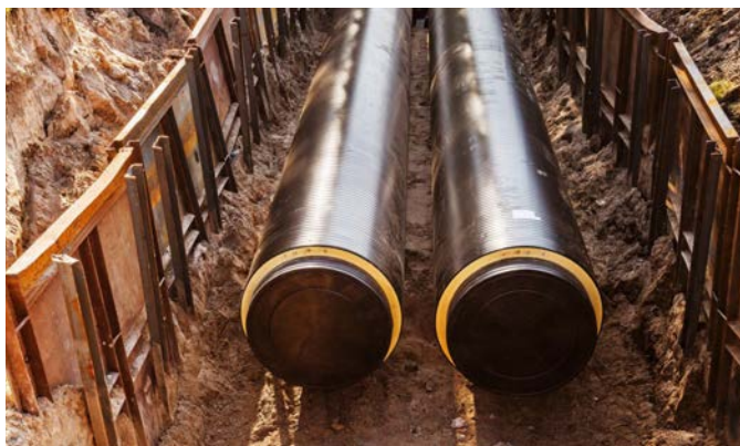
Abb. 22 Fernwärme-Rohre (Quelle: energieschweiz)
