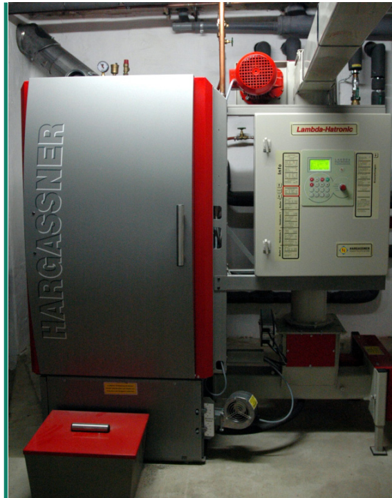
Abb. 19 Holzhacksnitzelheizung (Quelle: Hargassner)
