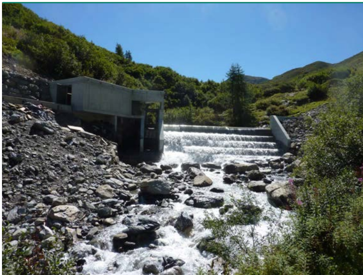
Abb. 9 Rechenanlage (Quelle: Entegra AG)
