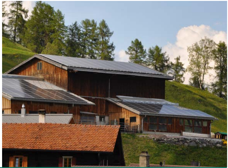
Abb.1 Photovoltaikanlagen in Tenna (Quelle: NPB)
